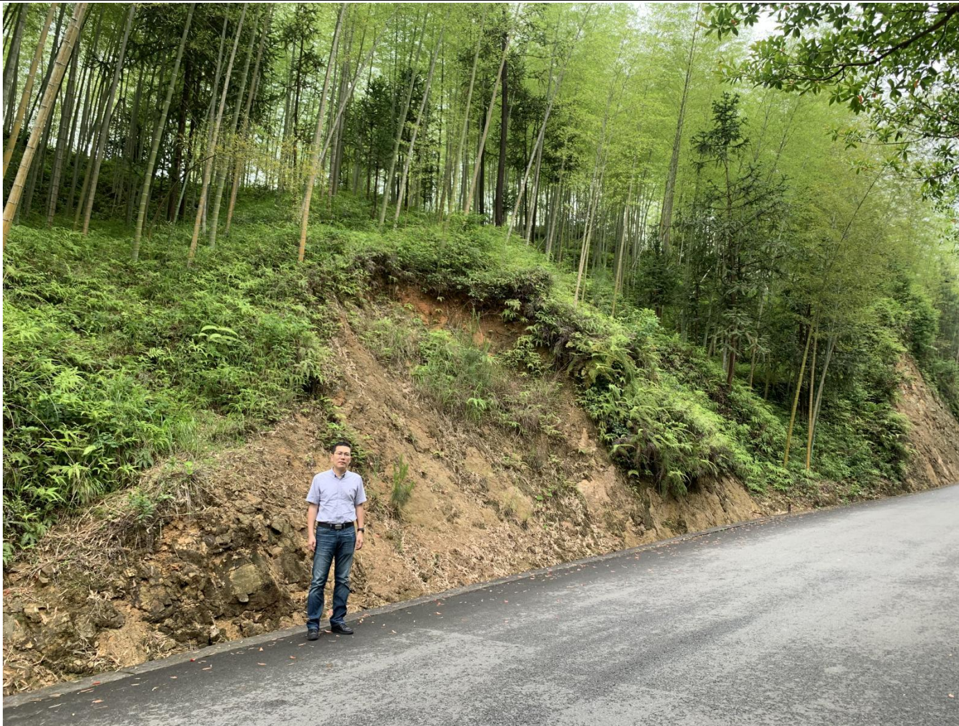
工程起点现场勘查照片
